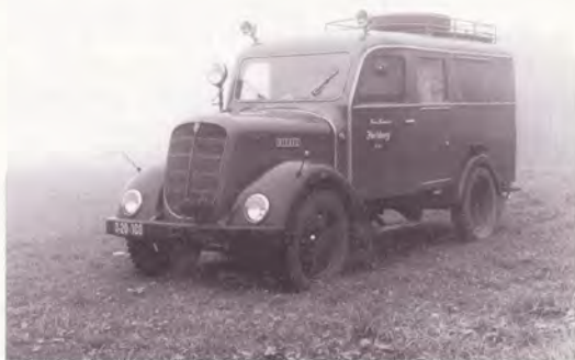
Umgebauter Paketwagen der Post. Er wurde am 05. 03. 1963 in den Dienst der FF Hochburg gestellt. Erstzulassung 1951 / 4 Zylinder Dieselmotor-45 PS / 2,545 Liter Hubraum / 6 Sitze
